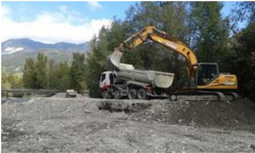
Réalisés entre septembre et octobre, ces travaux ont permis d'extraire les matériaux en surplus dans le lit de l'Arly, en amont et en aval du pont de l'Isle.
